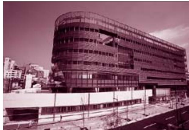
総合保健福祉センター。敷地面積4,107㎡、延床面積17,670㎡、鉄筋コンクリート造、一部鉄骨造
