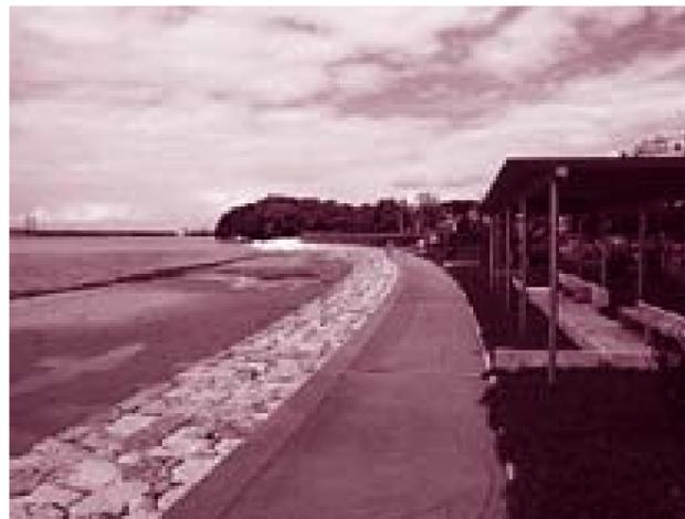
自然石を使った護岸工事が行われているエコパークゾーン。石と石の間に息づく生物が、海水を浄化するフィルターになる
